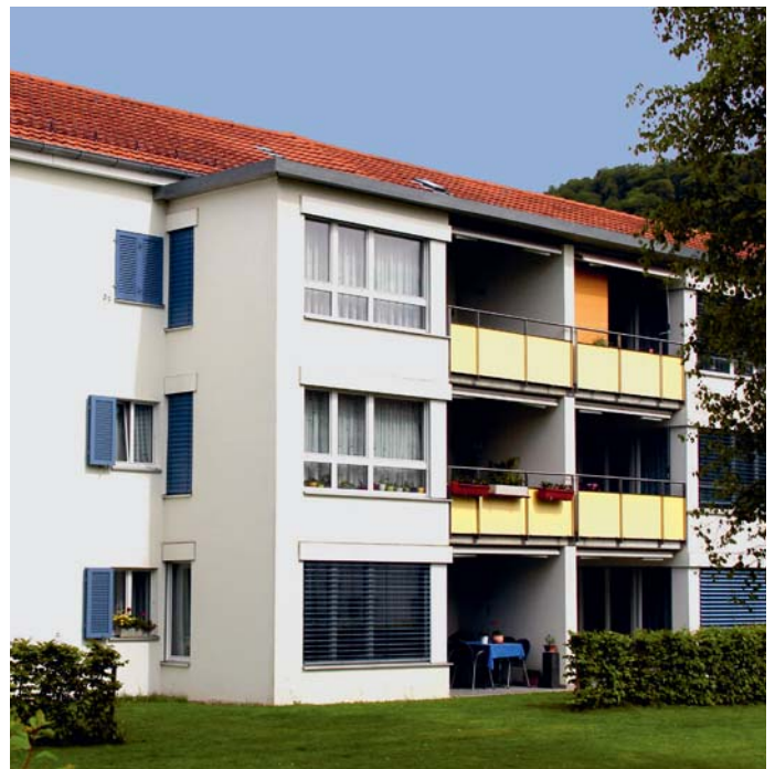
Der bestehende Balkon wurde für eine Wohnraumerweiterung genutzt und mit einem neuen, danebenliegenden Balkon erweitert.
